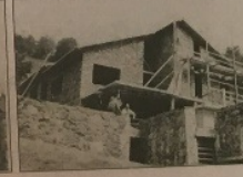
(dall'alto) Alcune tra le numerose ipotesi di realizzazione della casa per i residenti; Koenig preferiva l'utilizzo di semplici schizzi prospettici per esplorare le varianti costruttive; alcune fasi di cantiere
